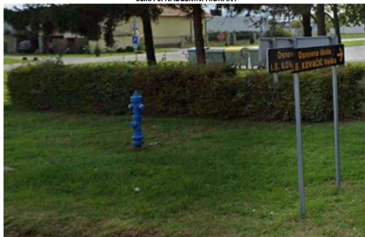
SLIKA 6: NADZEMNI HIDRANT
